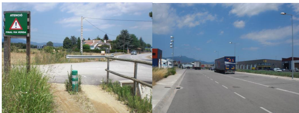
Fotos 8 i 9. Final carril bici GI-V-5332 i polígon de Montfullà.
