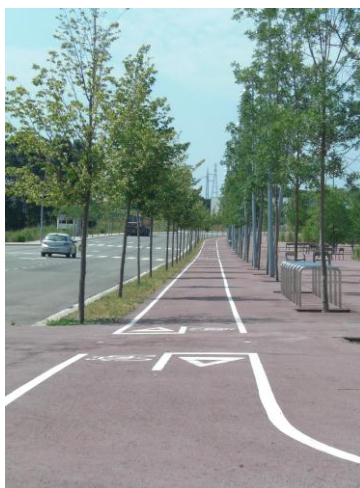
Foto 2. Tram del carril bici de Vilablareix
