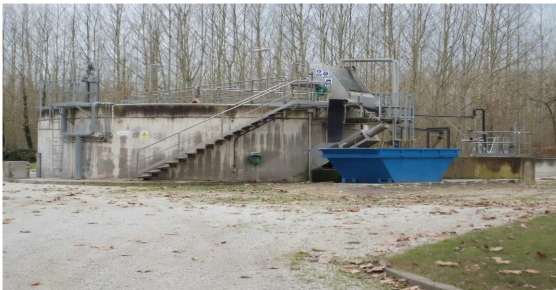
Figura 27. Estació depuradora d'aigües residuals de Riudarenes. Font: elaboració pròpia.
