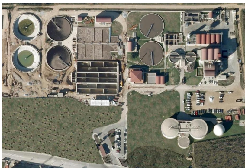
Figura 13. EDAR de Granollers. Font: Consorci per a la Defensa de la Conca del riu Besòs.
