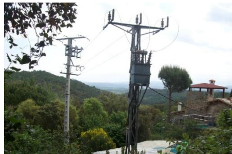
Figura 53: Línea elèctrica i habitatges en la zona 1.
