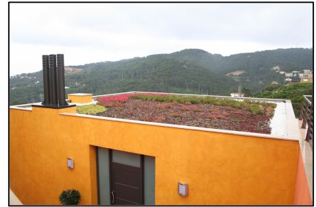
Coberta a Bagur de sedum
