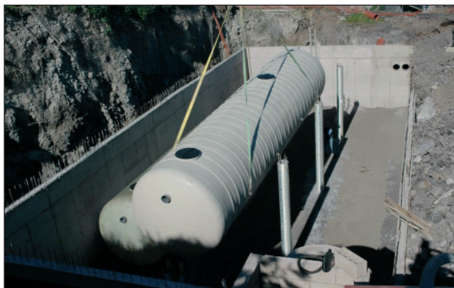
Equipo de 50 m³ en cubeto de obra para tráfico rodado.
