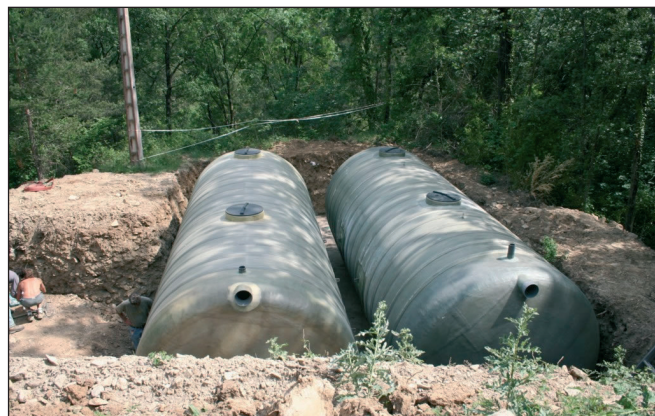
Instalación modular sin cubeto de obra.
