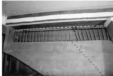
Trompeteria reial o de batalla, exterior de l'orgue de Cadaqués, típica dels orgues espanyols.
