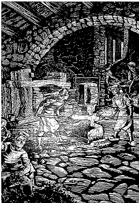
Treballadors de l'antic procediment català del ferro.
