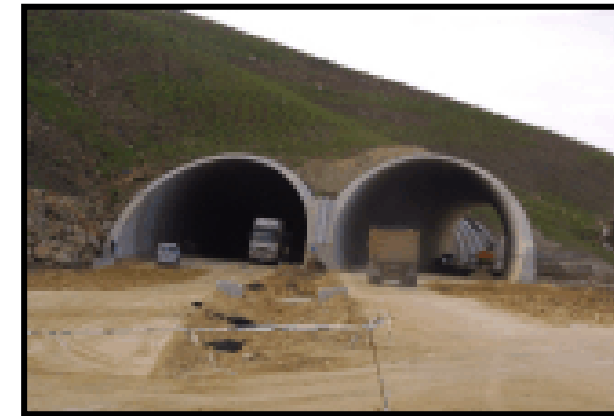
Figura 83. Exemple de falsos túnels utilitzats en autopista de Màlaga.
