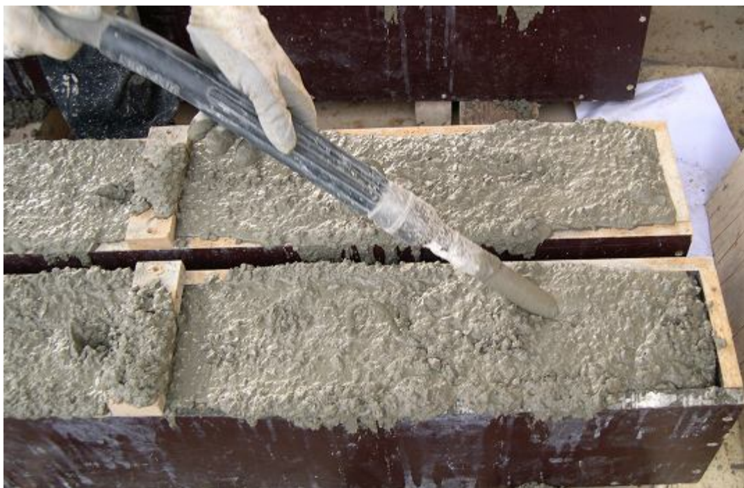
Figura 13: Formigonat del C1, cuba
