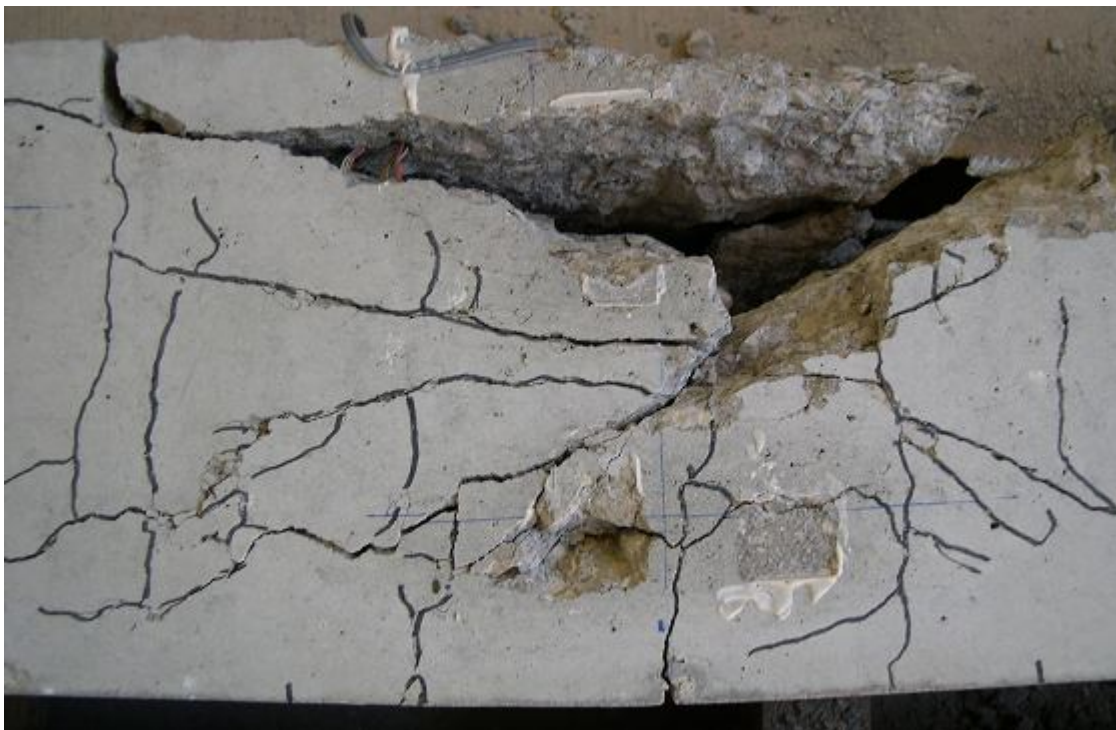
Figura 8: Resultat de l'assaig i fissures
