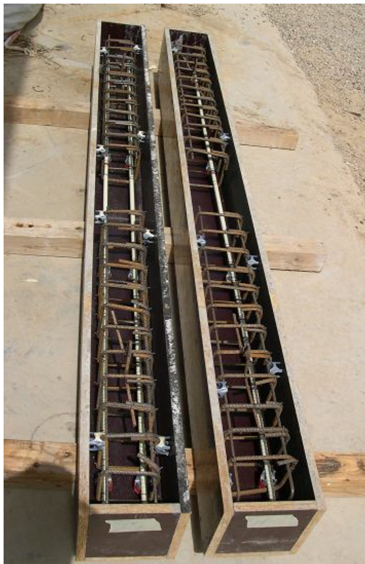
Figura 12: Armat del C1, formigonat cuba
