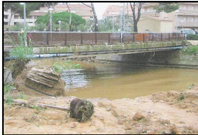
Foto 22.- Riera de Calonge. Vista del pont del Carrer de Conrad Vilar des d' aigua amunt
