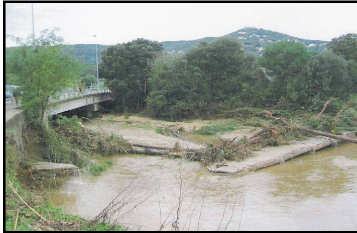
Foto 7.- Riera de Molins. Pont de la carretera GIV-667
