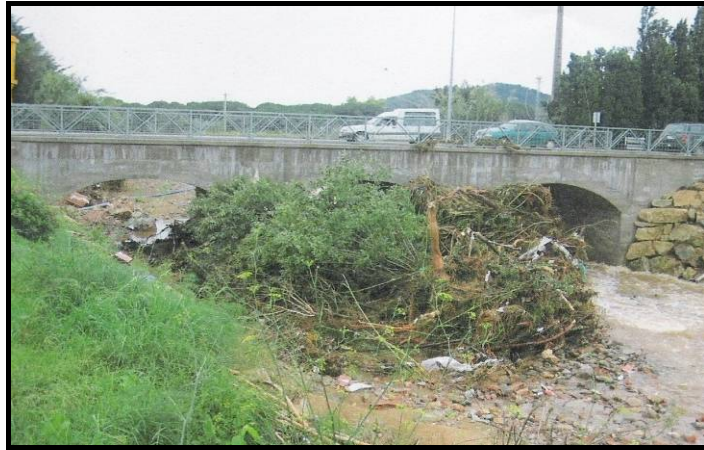
Foto 3.- Riu Rifred. Pont de la carretera de Romanyà vista des d'aigua amunt
