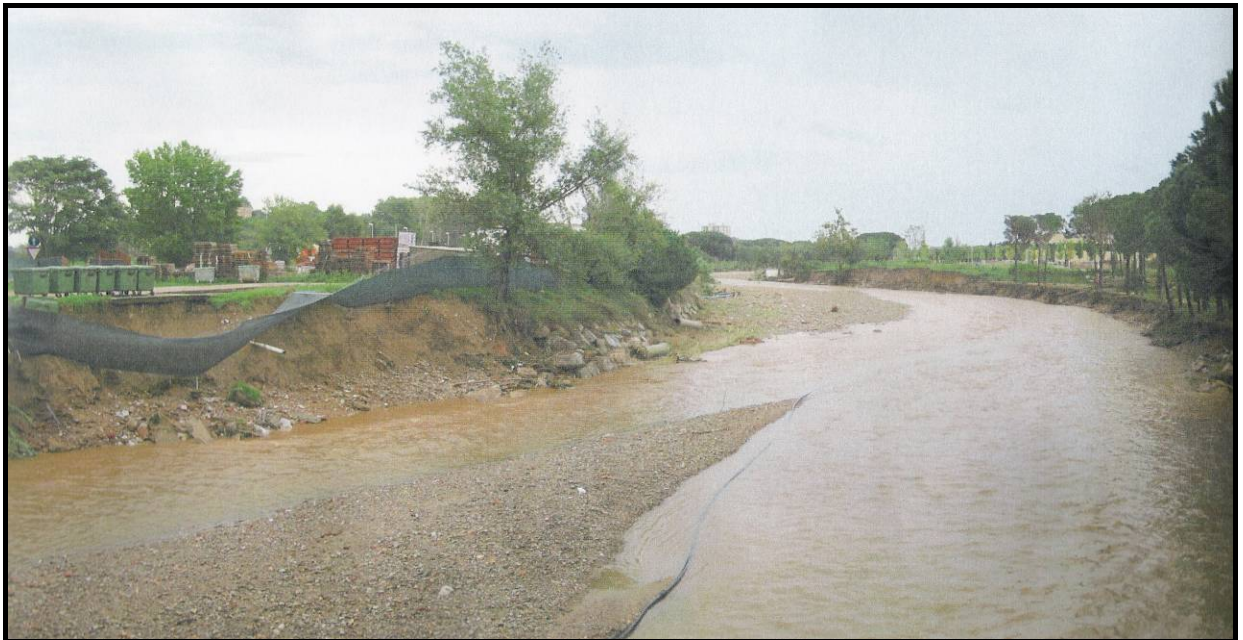
Foto 10.- Riera de Calonge. Vista cap a aigua avall des del pont de la carretera GIV-667
