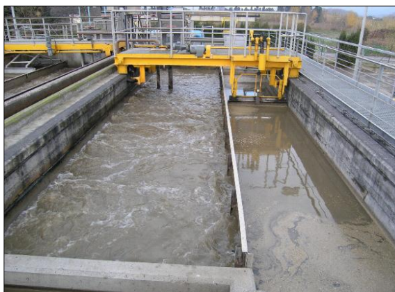
Figura 15. Fotografia del dessorrador-desgreixador.
