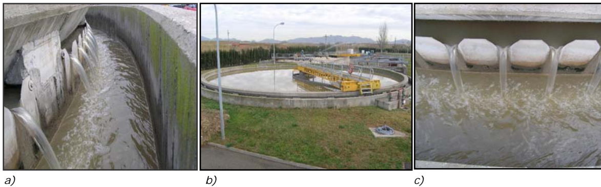
Figura 16. Fotografies del decantador primari. a) i c) Detall de la sortida de l'aigua. b) Decantador primari.
