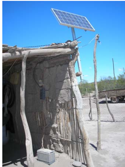
Imagen 26: Panel solar y batería. Fuente: Elaboración propia.
