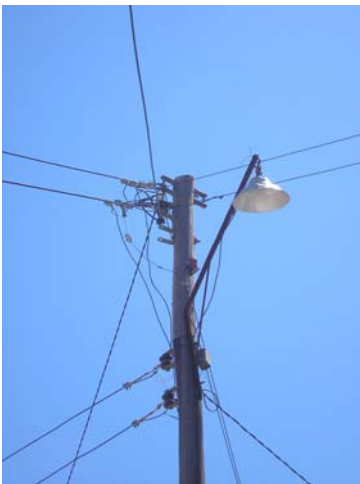
Imagen 25: Red eléctrica monofilar. Fuente: Elaboración propia
