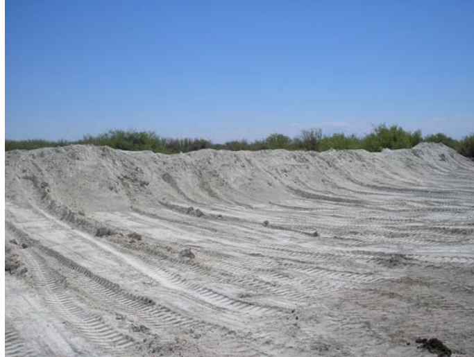
Imagen 5: Obras de contención. Fuente: Elaboración propia.
