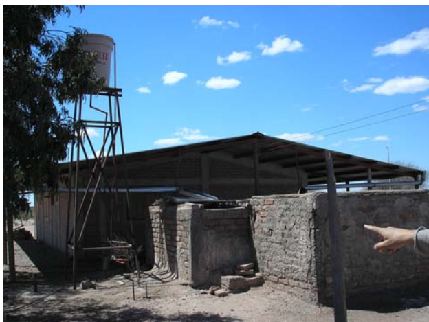
Imagen 24: Sistema de recogida del agua de lluvia. Fuente: Elaboración propia.
