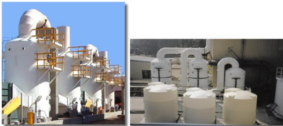
**Figura 2-13.** Fotografías de dos absorbedores situados en diferentes EDARs.
