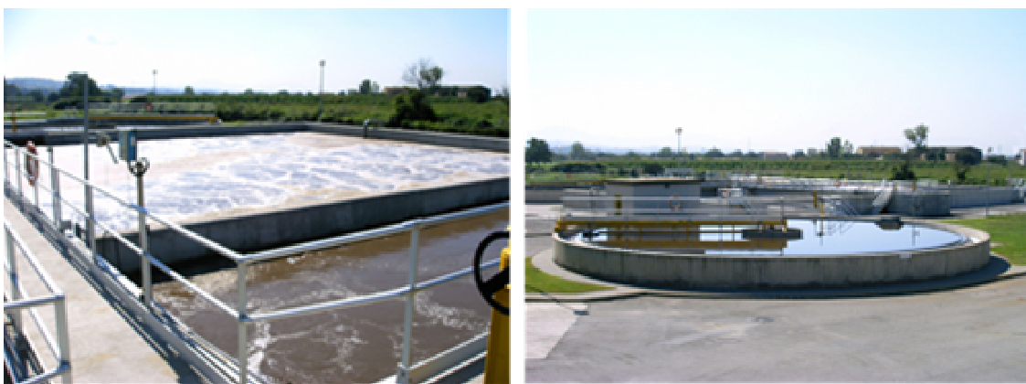
Figura 3.3. Reactor biològic (esquerra) i decantador secundari (dreta).
