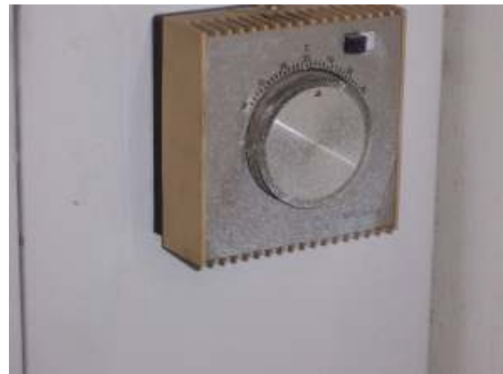
Fig. 18: Detall del termostat de la bomba Rhoss
