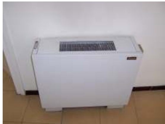
Fig. 14: Evaporador de la bomba Rhoss
