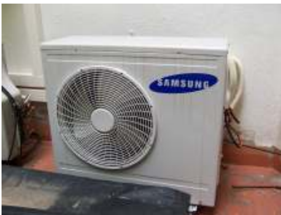
Fig. 19: Condensadora Samsung
