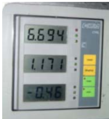
Figura 3.3.5: Display de la cel·la Pulcel de l'analitzador de xarxa circuitor CVMK-4C.
