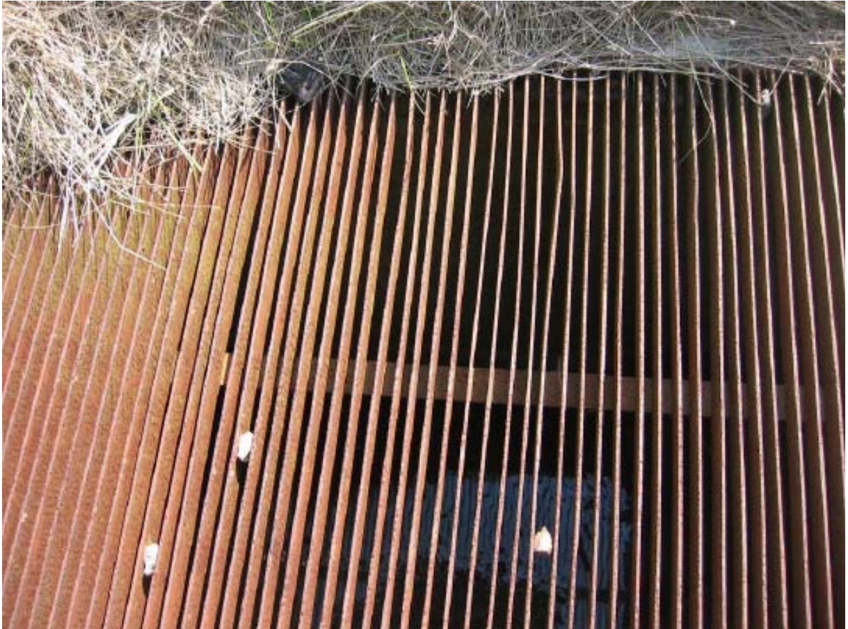
Figura 14. Arqueta de xarxa de pluvials. Profunditat i nivell de l'aigua
