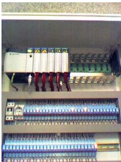
Imatge 7. Caixa Conexionat Rack
