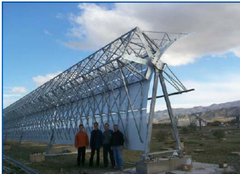
Imatge C-1: Foto de l'estructura d'un col·lector format per concentradors Eurotrough.
