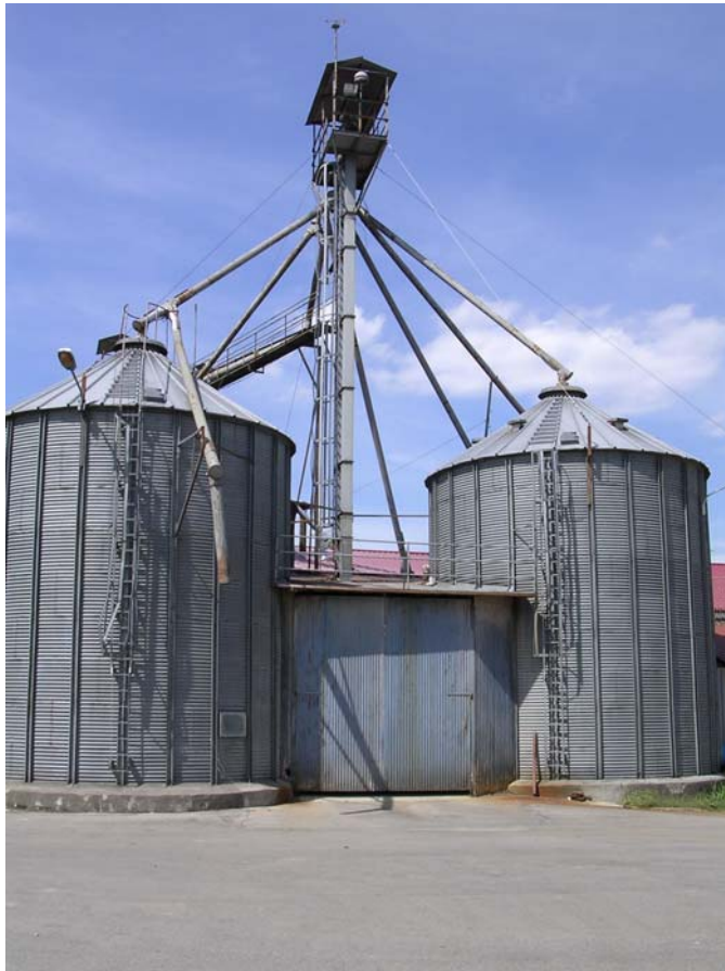
Figura 3. Sitges exteriors i porta de la tolva de recepció.
