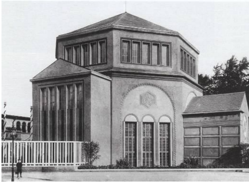
Peter Behrens 1868- 1940, Stanford Anderson, Electa, Milán 2002. Peter Behrens, Pabellón AEG de la Exposición de construcción naval alemana en Berlín, 1908. Vista exterior.
