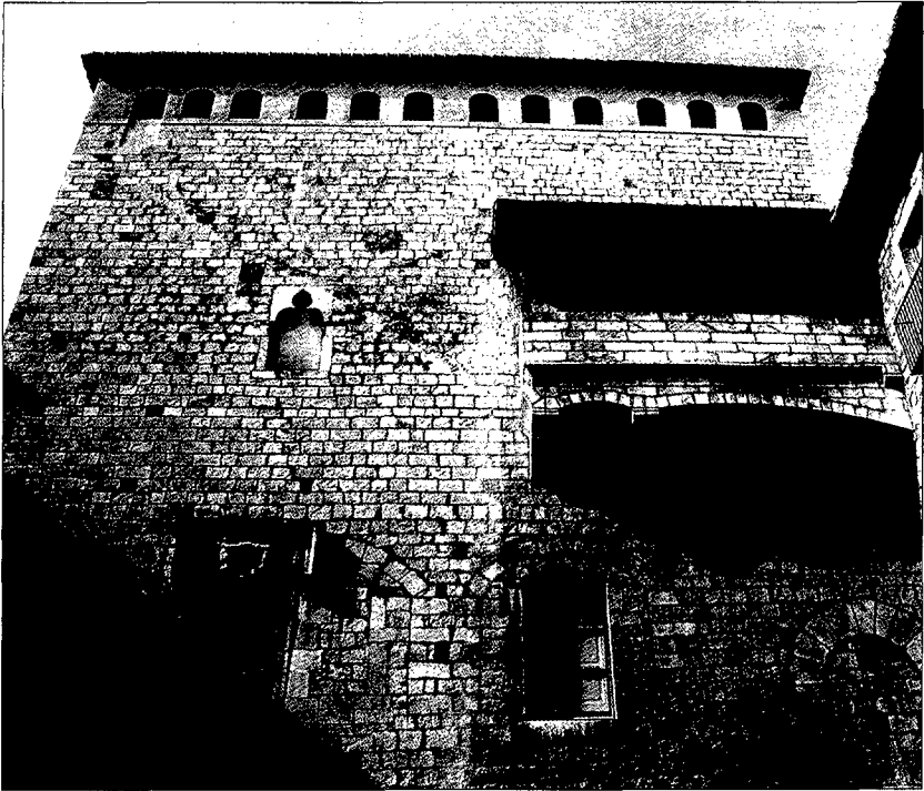
Fig. 5: Façana oriental de la torre de ponent vista des del pati. Les dues finestres rectangulars corresponen a la sala de paraments inferior, que primitivament tenia en aquesta paret dues portes de mig punt, una a cada banda. La de la dreta hi donava accés des de l'escala. La de l'esquerra donava pas a un passatge en el pati, perfectament oposat al que hi havia a l'altre costat, al qual s'accedia des del saló del tron. El balcó dona pas a la sala de paraments superior, que era nova al 1369, i d'ell en sortia una escala penjada que passava per sobre la finestra i acabava en la finestra més meridional del terrat, que abans d'igualar-la amb les altres n'era la porta d'accés. L'escala ha desaparegut, però ha deixat clares evidències de la seva existència a la paret.
