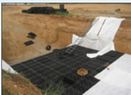
Depósito de infiltración GRAF de 1.195 m 3 construido
