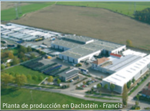
Planta de producción en Dachstein - Francia -
