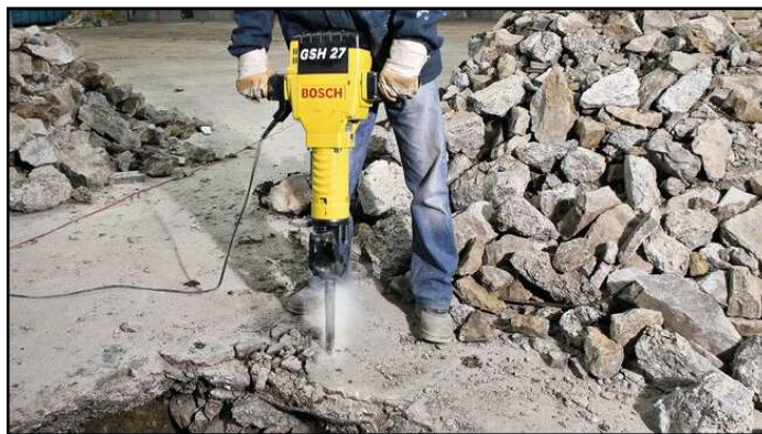
Figura 53. Extracció de formigó. Font: www.bosch.com
