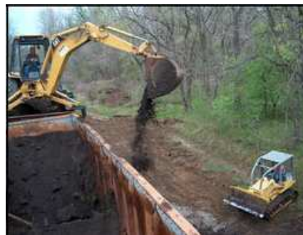
Figura55. Excavació de terres. Font: Informe Lyman
