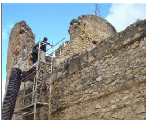
Figura 57. Restauració d'un element arquitectònic.
