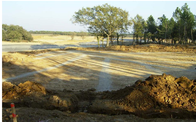
Imatge 20 : Drenatges subterranis per estalvi d'aigua dels Tees de sortida. Font: Jornada_Greenkeepers_Mas Badia_Nov_04..
