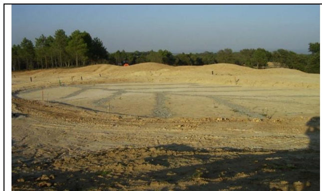
Imatge 24 Sòl de Green i drenatges subterranis durant el procés de construcció. Font: Jornada_Greenkeepers_Mas_Badia_Nov_04.
