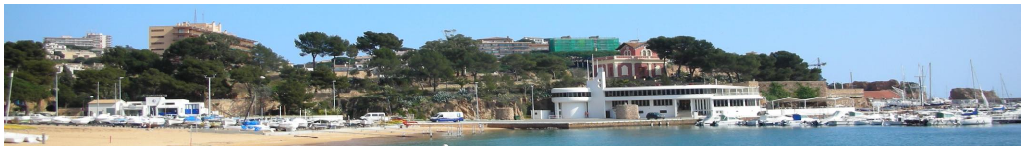
Vista de la façana de ponent del conjunt del Fortim, cedida per Ports de la GC
