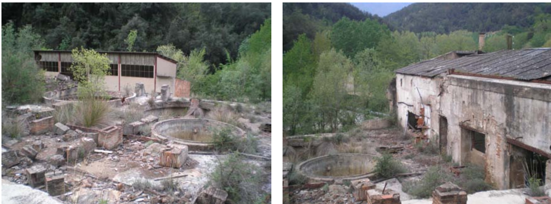
Figures 8 i 9. Fotografies de l'estat actual de la planta de tractament de la Mina d'Osor
