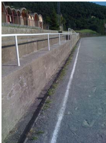
Imatge 3.- Graderies de l'extrem oest del camp situades a menys de un metre de distància de la línia de banda.
