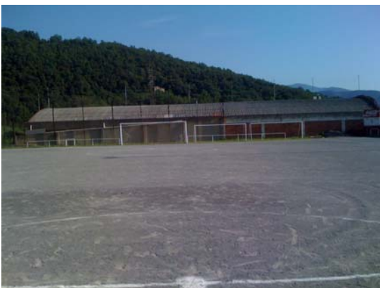
Imatge 5.- Extrem nord. Al fons, rere la porteria, es pot observar la única nau que queda de l'antiga filatura que es va incendiar. El teulat d'aquesta nau està en molt mal estat i suposa un perill quan s'hi ha d'accedir a recollir pilotes.
