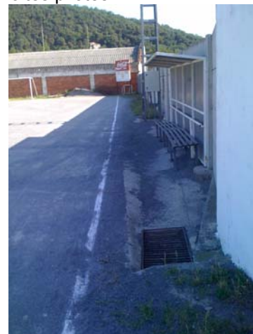
Imatge 6.- Extrem est, zona de banquetes. La paret també està molt propera de la línia de banda suposant un perill pels jugadors.
