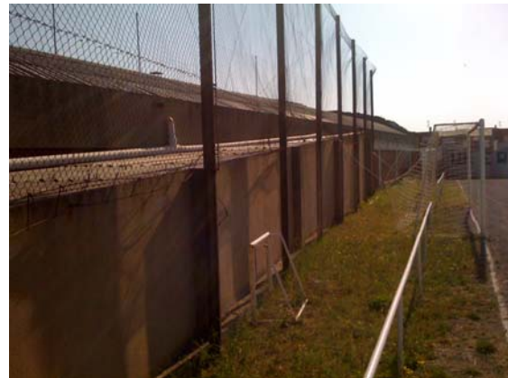
Imatge 4.- Extrem nord del camp. Rere la xarxa metàl·lica de la foto es troba un teulat de planxa de fibrociment en molt mal estat on hi cauen moltes pilotes.
