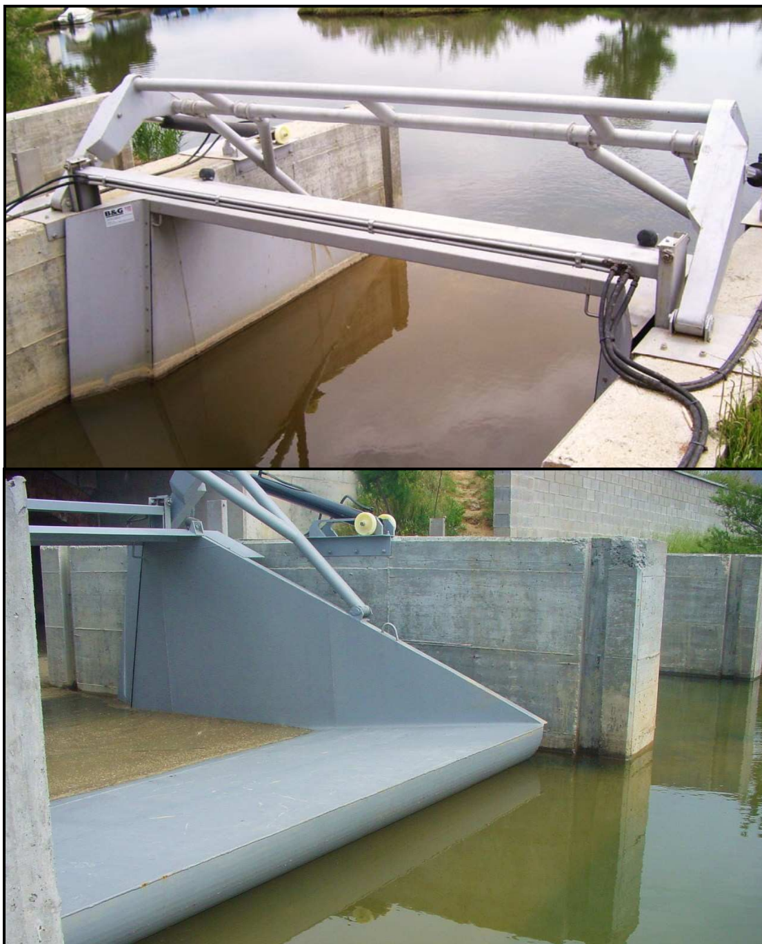
Figura 8.5. Imatges de la comporta ja existent.
