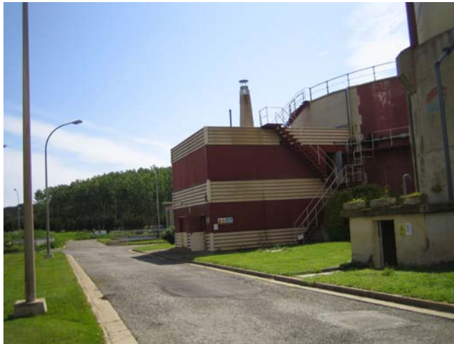
Fig. 44. Exemple de digestor anaerobi, EDAR de Palamós. Font: Elaboració pròpia.
