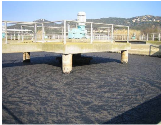
Fig. 30. Tanc digestor aerobi. Font: Elaboració pròpia.
