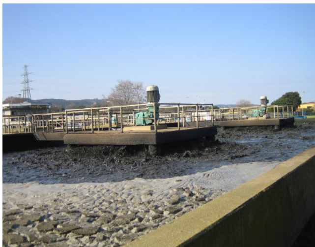
Fig. 23. Reactor biològic. Font: Elaboració pròpia.
