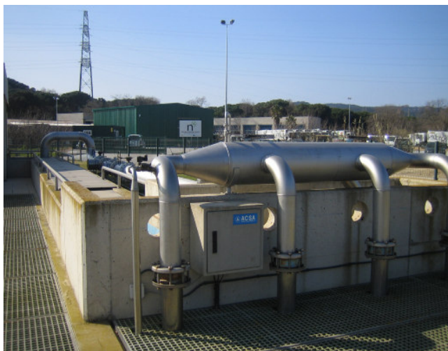
Fig. 26. Tub UV. Font: Elaboració pròpia.
