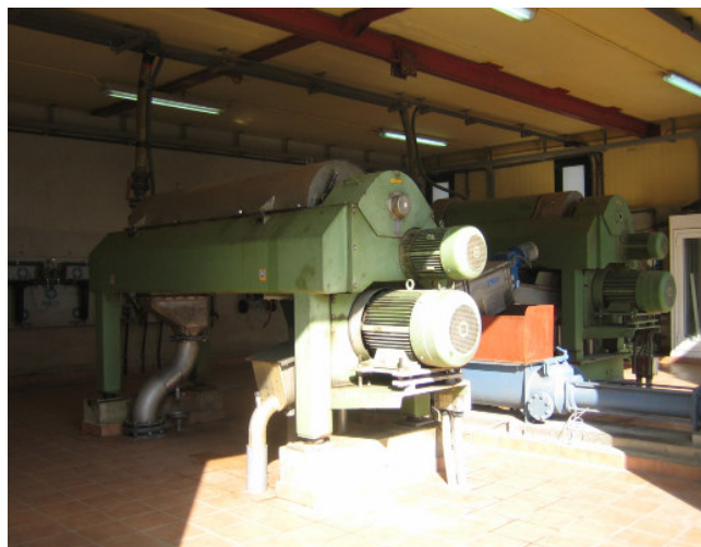
Fig. 32. Centrífugues. Font: Elaboració pròpia.
