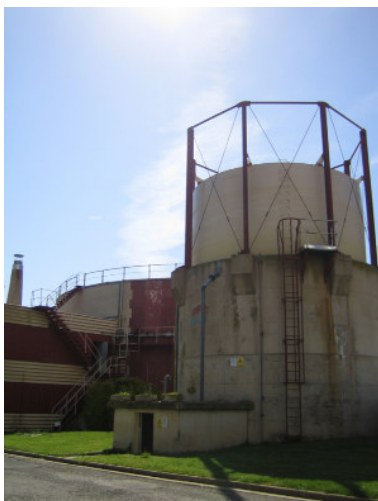
Fig. 45. Exemple de gasòmetre. EDAR de Palamós. Font: Elaboració pròpia.
