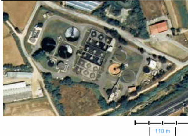
Fig. 4. Vista aèria de la EDAR. Font: Gencat.
