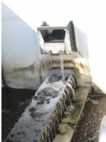
Fig. 25. Filtre de sorra. Font: Elaboració pròpia.
