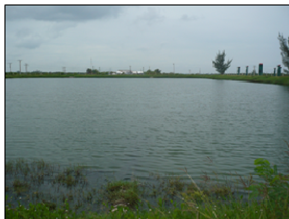
Imagen 13: Laguna de Oxidación Oasis (Fuente: CIMAB, 2008)
