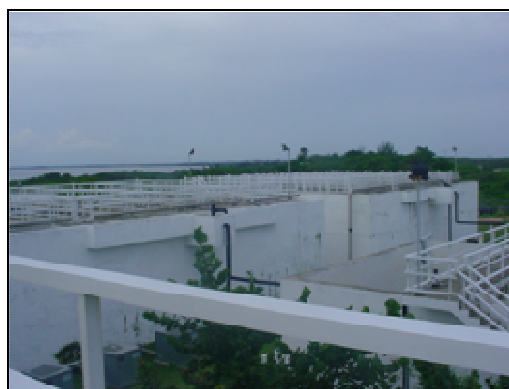
Imagen 14: Planta de tratamiento Hicacos (Fuente: CIMAB, 2008)
