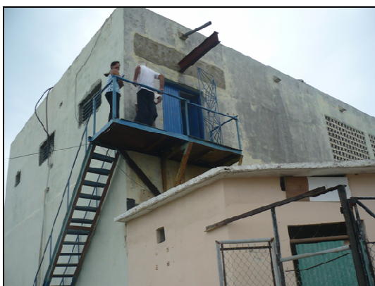
Imagen 10: Planta de Tratamiento Palmeras (Fuente: CIMAB, 2008)
