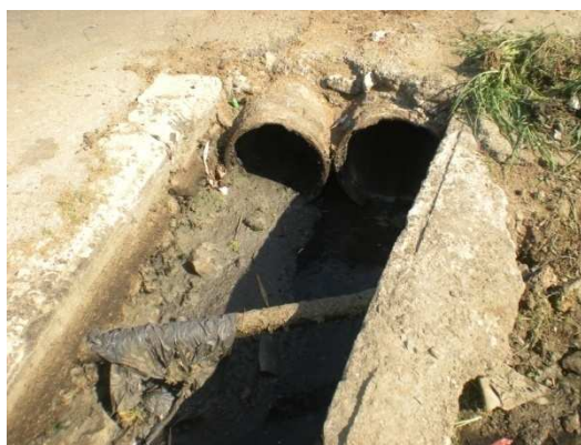
Imagen 2: Zanja de vertimiento de aguas residuales de la empresa Cuba Ron (Fuente: propia)
