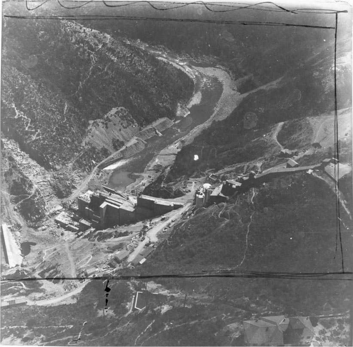
(Imatge 19: Detall de la construcció de la presa l'any 1953).
