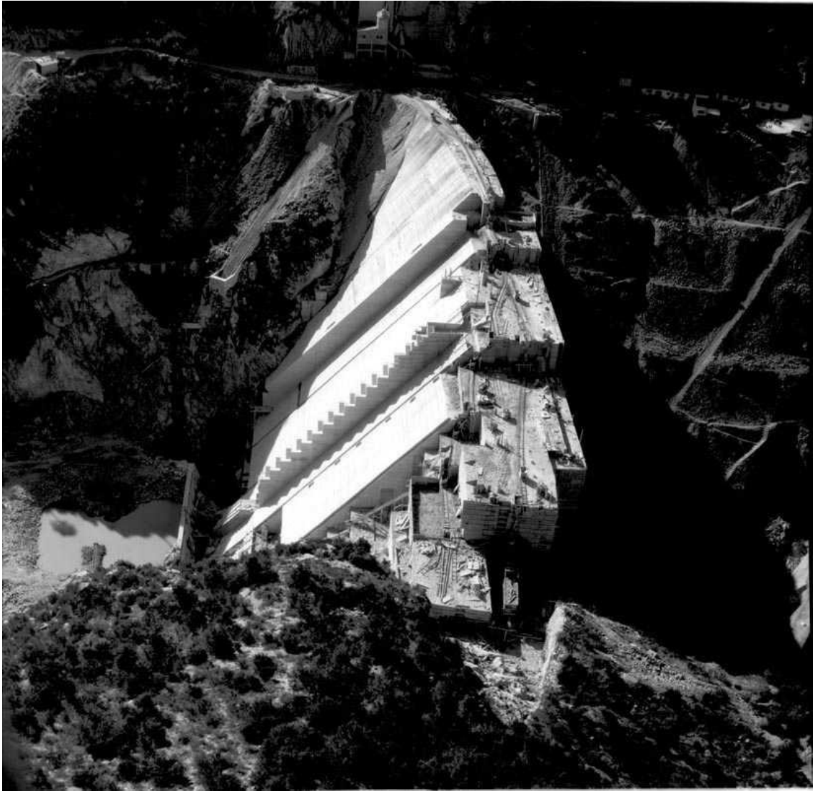
(Imatge 21: Detall de la construcció de la presa l'any 1955).
