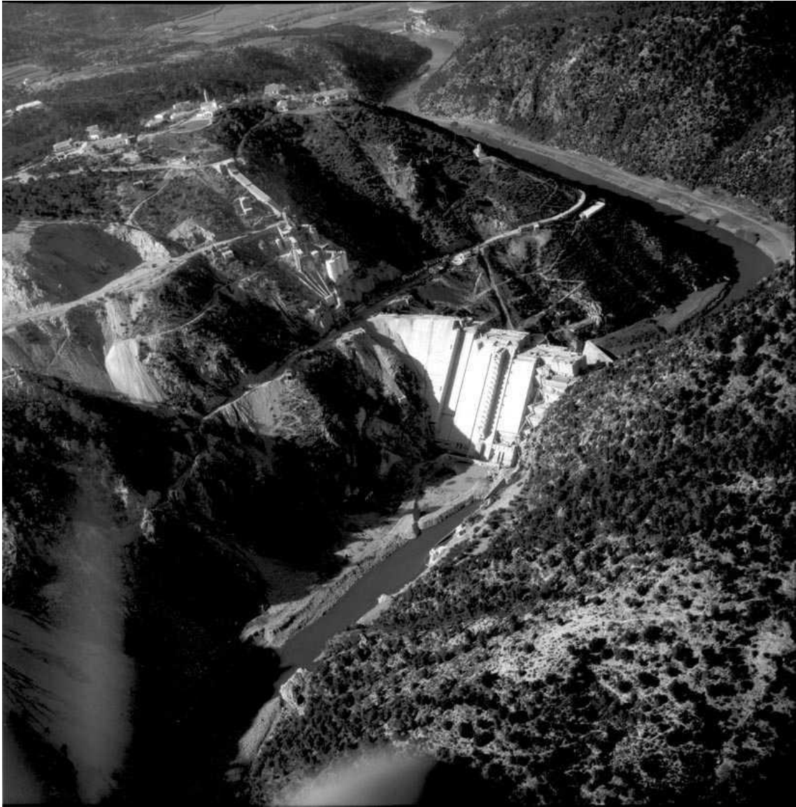
(Imatge 20: Panoràmica construcció de la presa l'any 1955).
