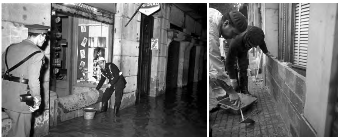
Figures 3.16 i 3.17: Un guàrdia col·locant una protecció davant un establiment a la pujada del Pont de Pedra a l'aiguat de 1962. Dreta: paletes construint un mur de protecció, 1970
