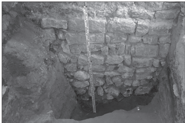
Figura 6. Sondeig realitzat a l'interior de la torre.
