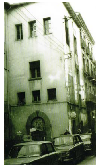
8 "Antiga clínica del Dr. Fàbrega al carrer Sant Rafael s'enderrocava per fer-hi el nou edifici de Consultes Externes." 1971. AAH
