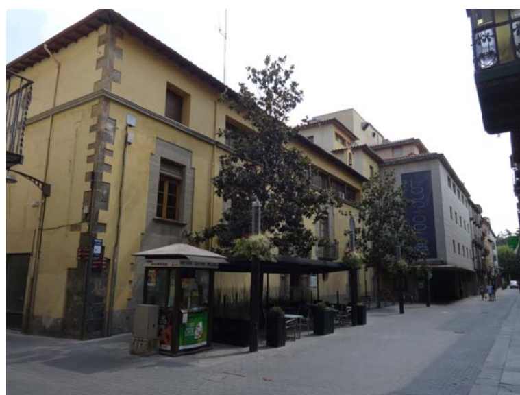
FOTO 4. Façana exterior del carrer Sant Rafel
