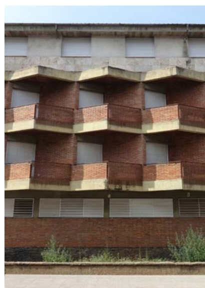
Llenguatge 1. Obra vista
