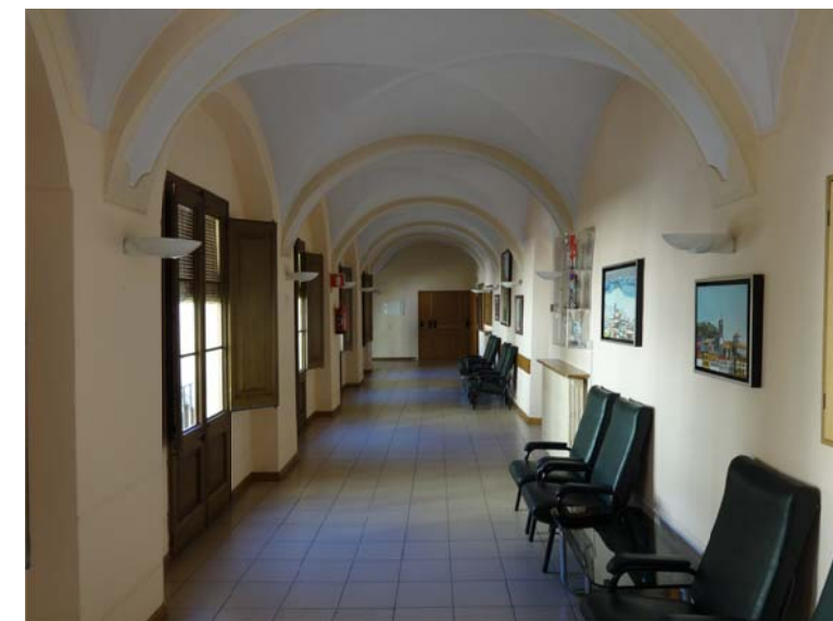
Passadís interior edifici històric
