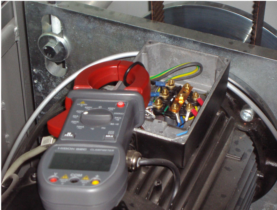
Figura 3.16: Pinça amperimètrica digital durant les mesures d'intensitat del motor d'arrossegament.
