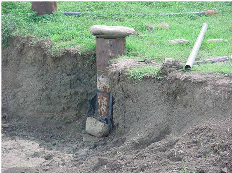
Imagen # 25 El tubo enterrado es un poso (perforación de 10 metros de profundidad) del cual se extrae agua para un pequeño embalse para ser utilizada en el regadío.
