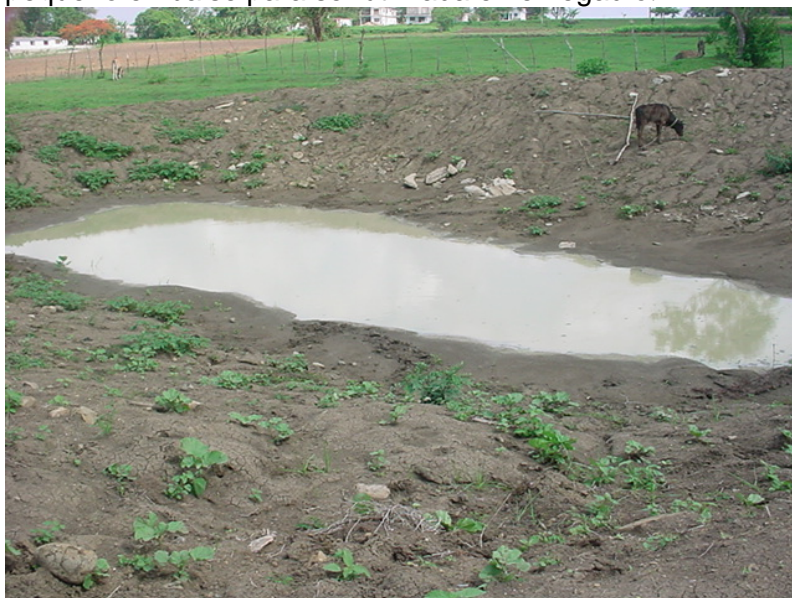
Imagen # 26 Pequeño embalse construido a fin de acumular agua extraída con una turbina del manto freático, esta modalidad para el regadía se está poniendo de moda a partir de fines de 1990, como fruto del aumento de los períodos de sequía.
