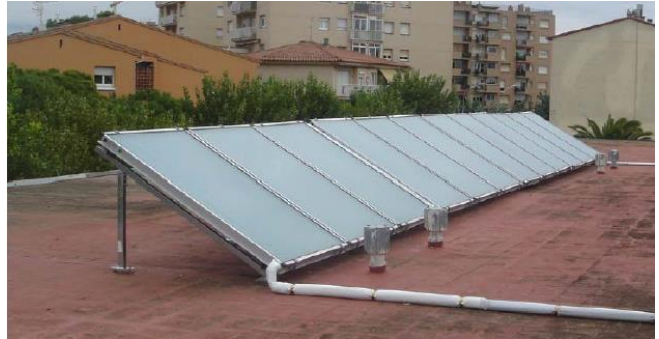
Fig. 30. Plaques tèrmiques coberta Pavelló. (Font: Ajuntament)
