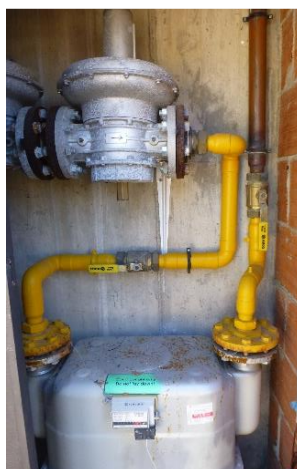
Fig 31: Comptador gas Piscina. (Font: Pròpia)
