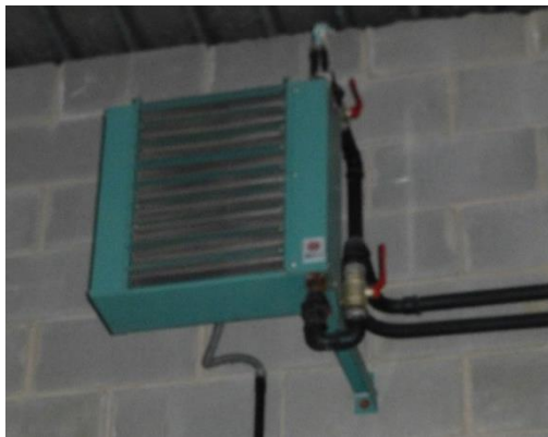
Fig. 23. "Aerotermo" pista (Font: Pròpia)
