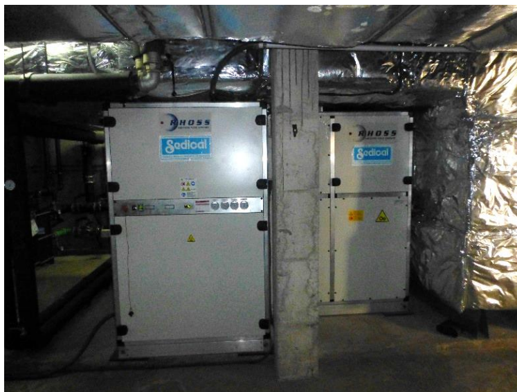
Fig. 18 Deshumectador situat al soterrani. (Font: Pròpia)
