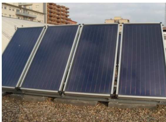
Fig. 29. Plaques tèrmiques coberta annex. (Font: Ajuntament)
