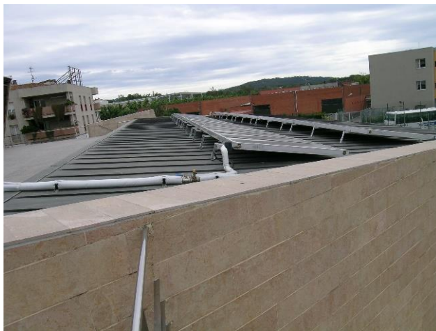
Fig. 28. Plaques tèrmiques coberta gimnàs. (Font: Pròpia)
