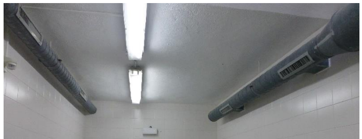
Fig. 16. Conductes provinents dels fan colis als vestidors. (Font: Pròpia)
