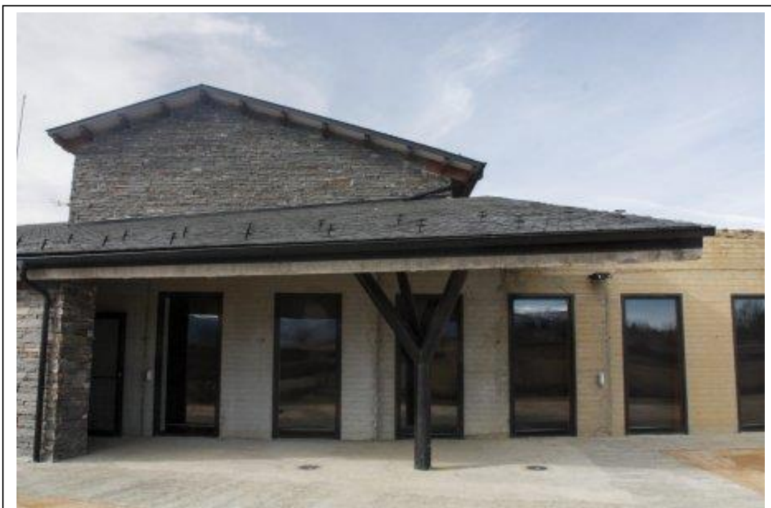
Figura nº 1. Façana del centre d'interpretació Espai Ceretània . Imatge d'autor.
