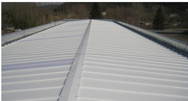
Figura 3-2. Exemple de coberta
