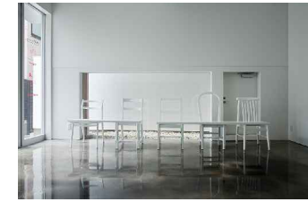
FORMIGÓ POLIT TRACTAMENT EPOXI interiors
