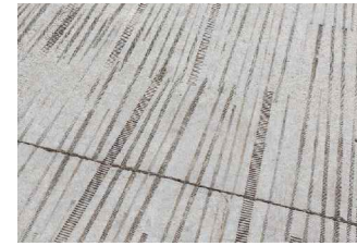
FORMIGÓ RASPALLAT AMB TEXTURA exteriors
