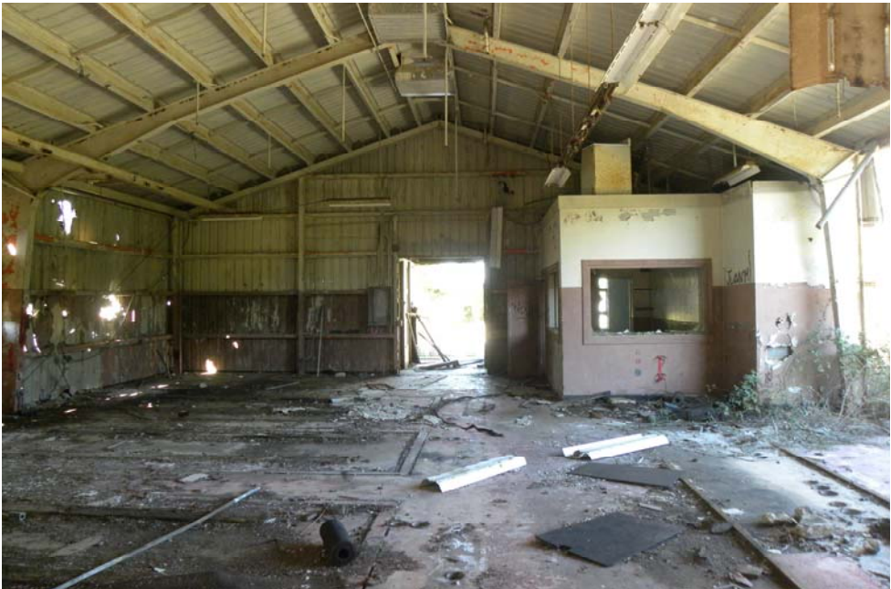
Edifici amb estructura de perfils metàl·lics
