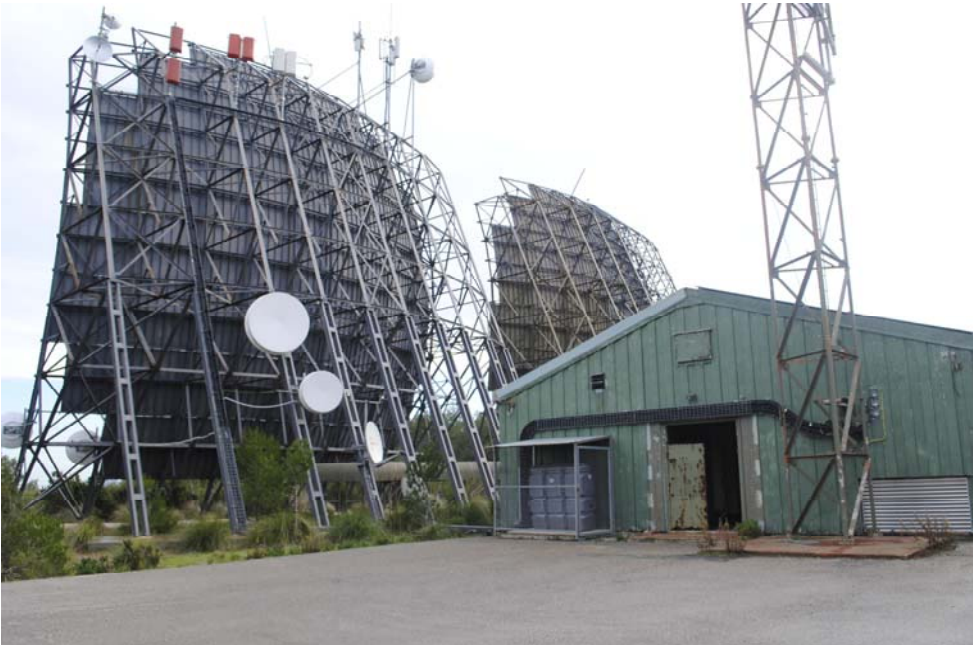
Edifici telecomunicacions e
