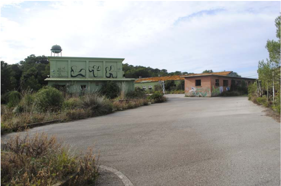
Vista zona sud b
