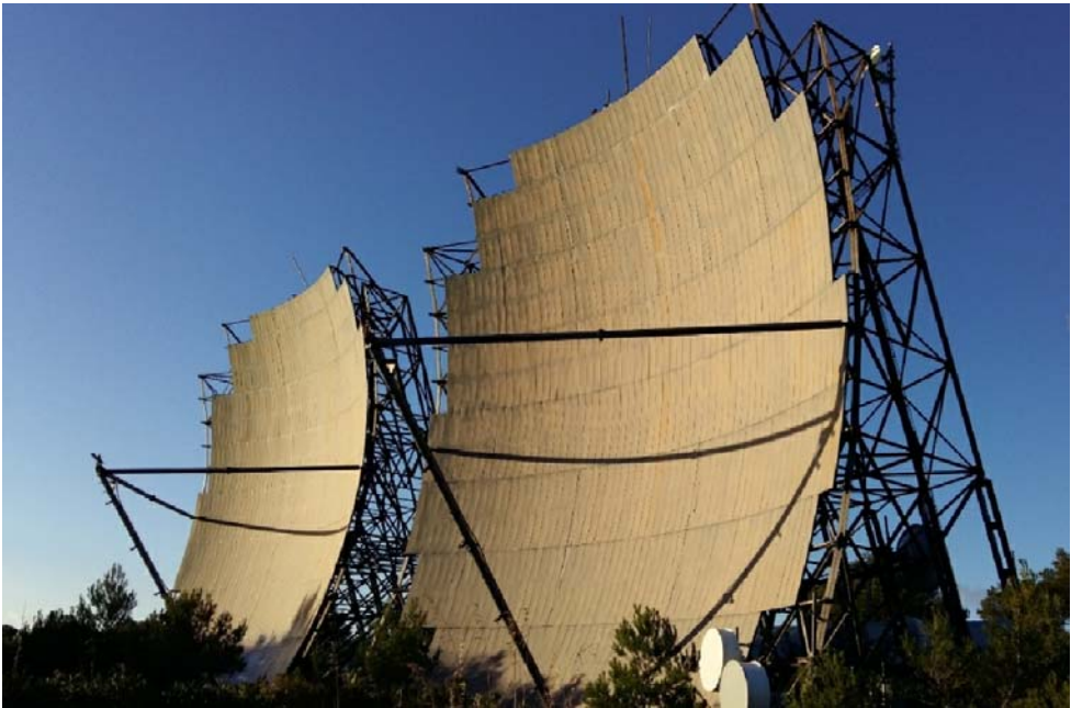
Fotografia d'estat actual
