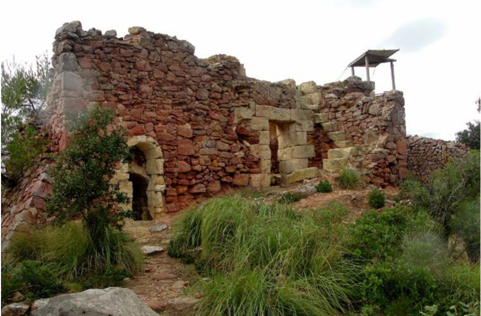
Fotografia d'estat actual
