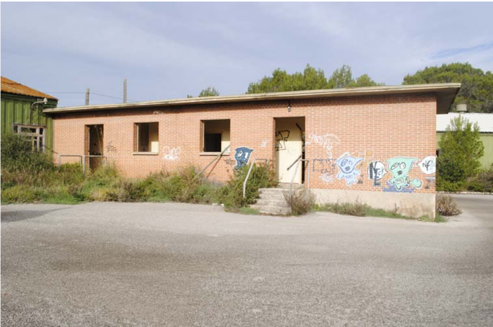
Edifici amb estructura de murs d'obra de fàbrica c
