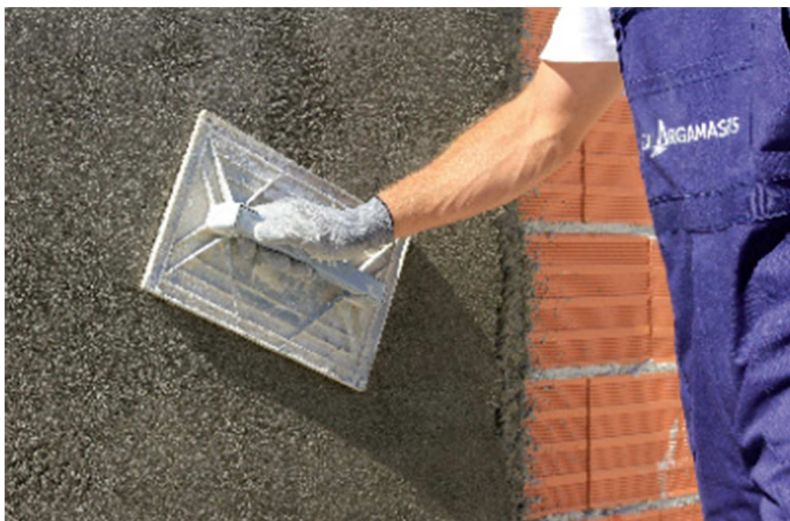
pasar la talocha a la superficie para permitir el agarre de la capa posterior (mortero fino de cal-arena)
