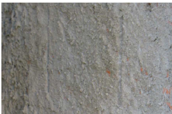
preparación soporte con lechada de mortero de cal
