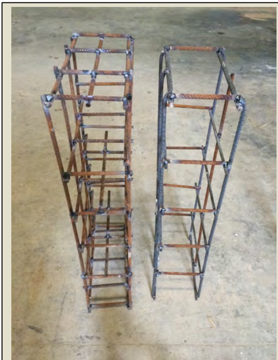
Imatge 5.1.2.1: Tipologies d'armat.
