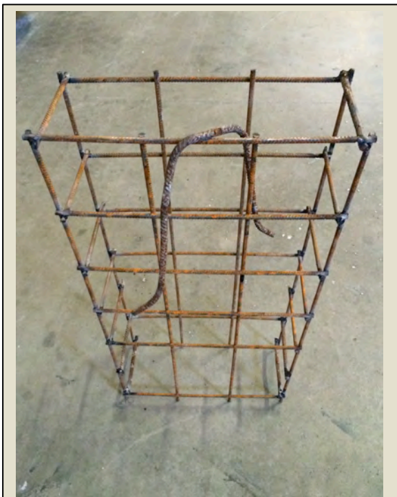
Imatge 5.2.2.1: Col·locació armat obert.
