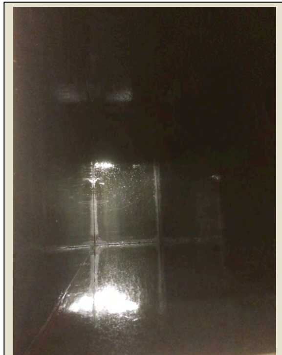
Imatge 4.16: Untat amb oli desencofrant (planxa).
