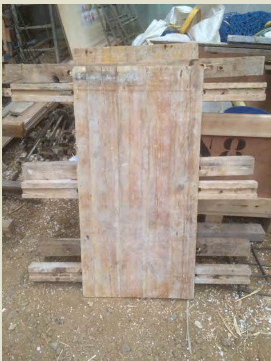
Imatge 4.3: Preparació material d'encofrat (tauler de pi flandes de 20mm de gruix). Foto: Albert Coromina / Font: Pròpia
