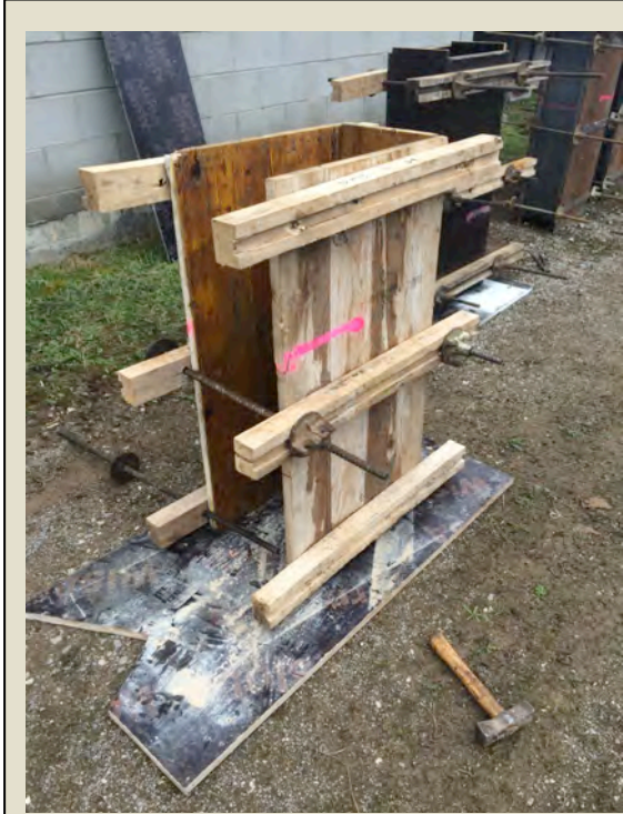
Imatge 4.21: Muntatge motlle tauler tricapa. Foto: Albert Coromina / Font: Pròpia
