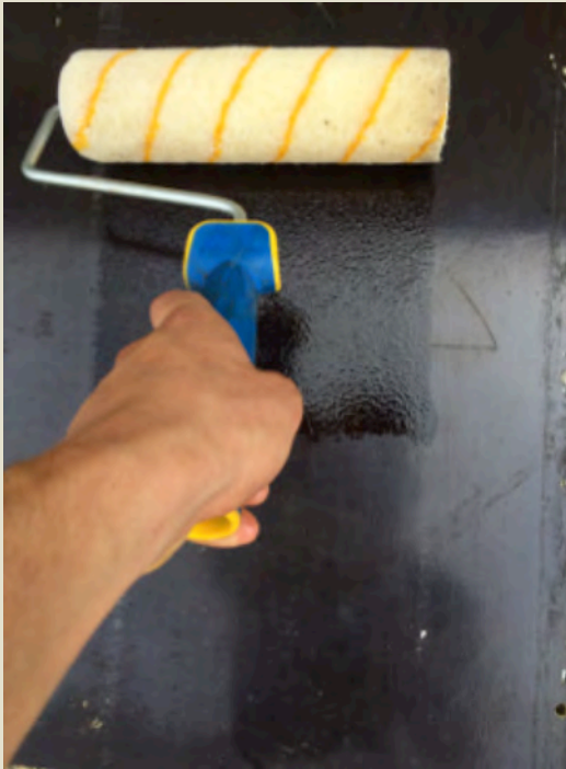
Imatge 4.17: Untat amb oli desencofrant (tauler fenòlic).
