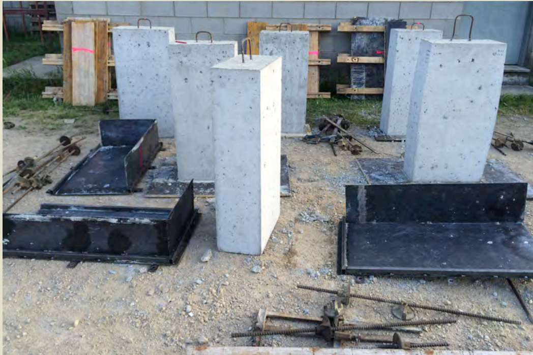
Imatge 4.53: Desencofrat general. Foto: Albert Coromina / Font: Pròpia
