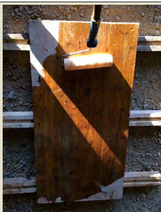
Imatge 5.2.2.9: Muntatge motlle tauler. Foto: Albert Coromina / Font: Pròpia
