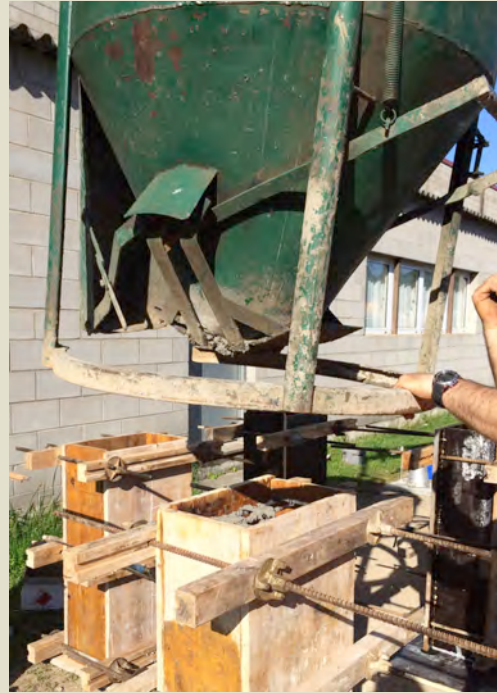
Imatge 4.34: Procés d'abocat a uns 50 cm d'alçada respecte l'encofrat.
