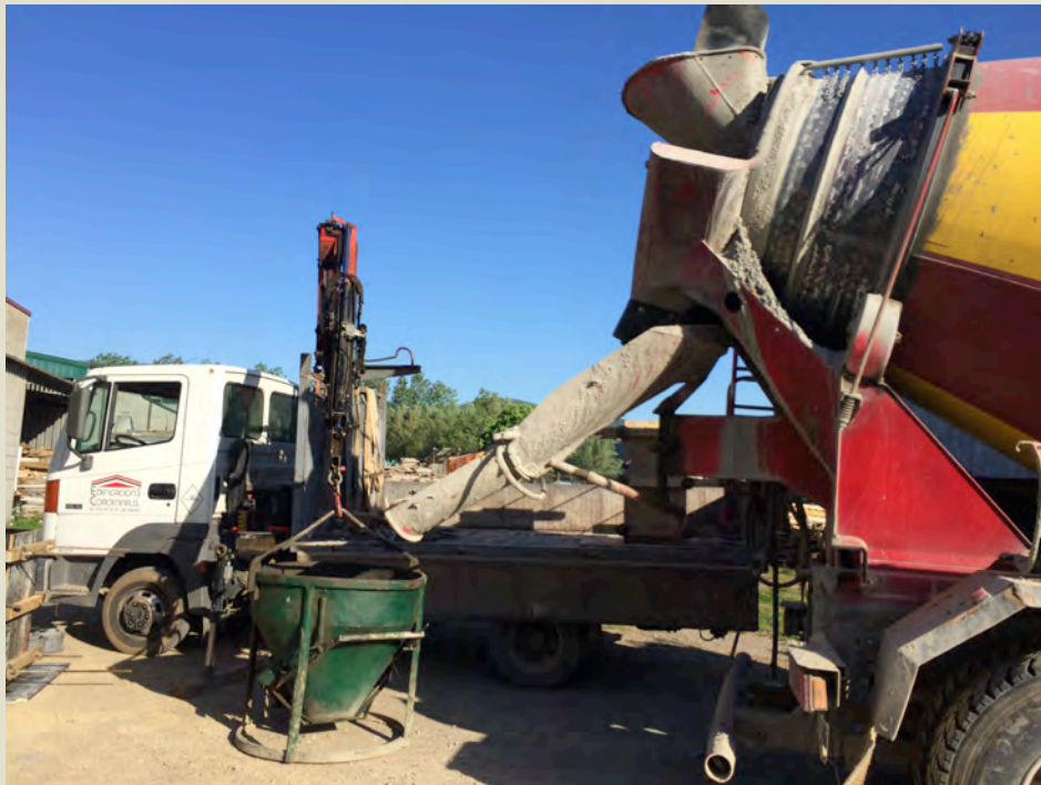
Imatge 4.32: Procés de formigonat amb cubilot.
