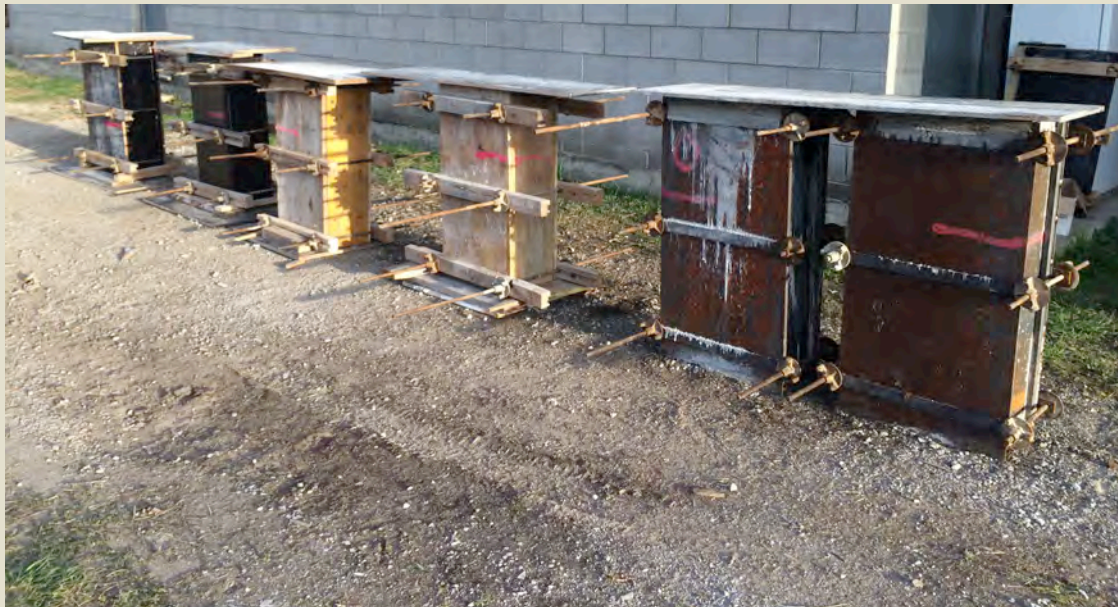
Imatge 5.3.2.5: Provetes apunt per formigonar i tapades per protegir el producte desencofrant.
