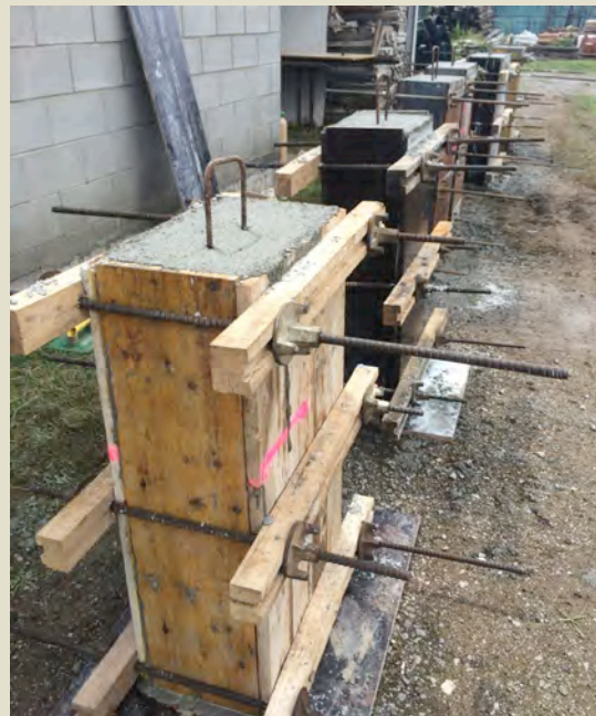
Imatge 5.2.2.22: Procés de formigonat acabat.
