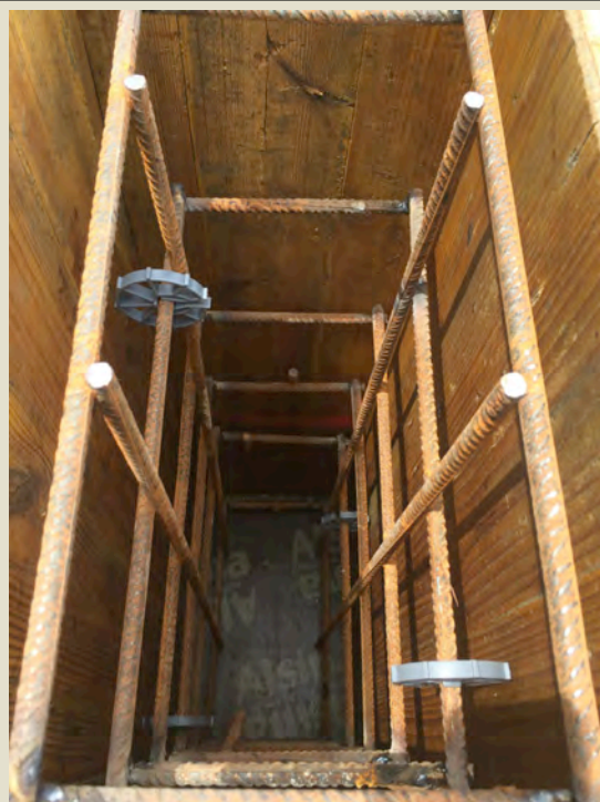
Imatge 5.2.2.13: Col·locació de separadors de 40mm.
