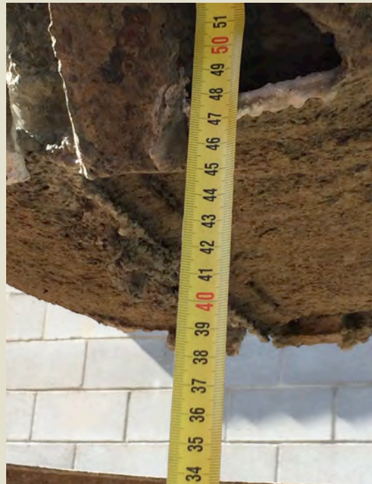
Imatge 4.36: Alçada d'abocat entre 40-50cm.
