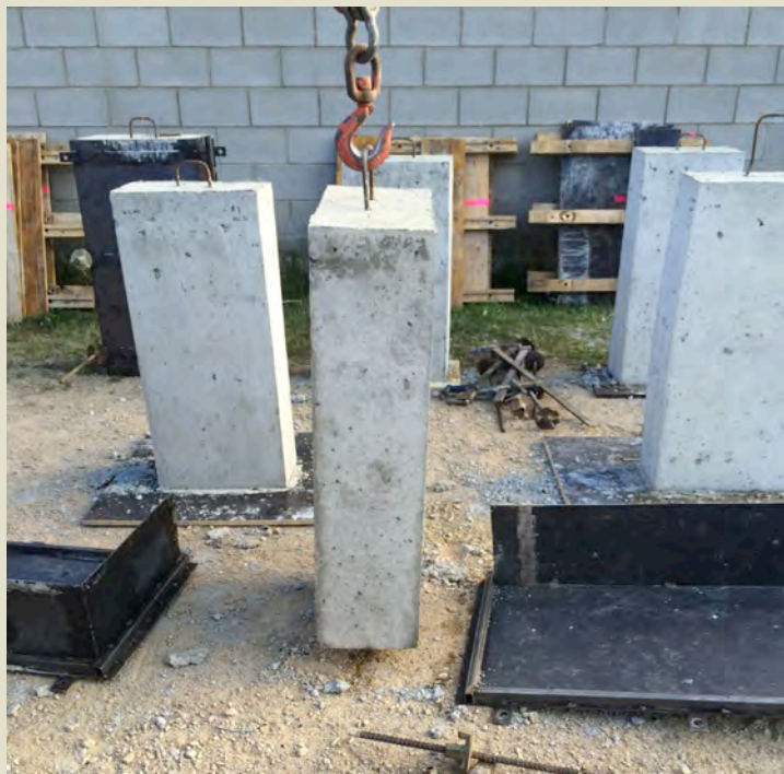
Imatge 5.1.2.28: Procés de desencofrat general.
