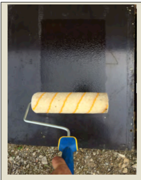
Imatge 5.2.2.6: Untat amb oli desencofrant amb dissolvent i base cera. Contraxapat de fenòlic. Foto: Albert Coromina / Font: Pròpia
