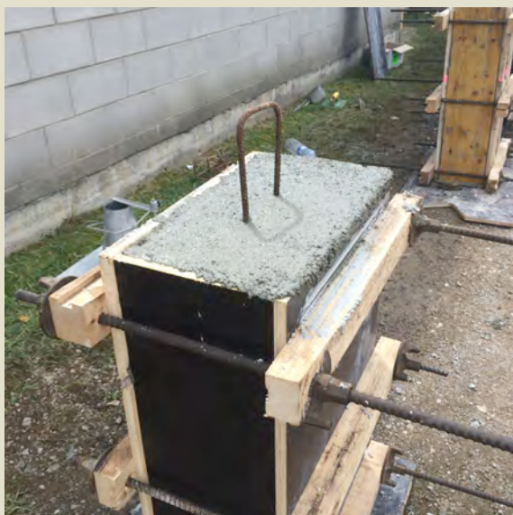
Imatge 5.2.2.21: Formigonat motlle fenòlic acabat.
