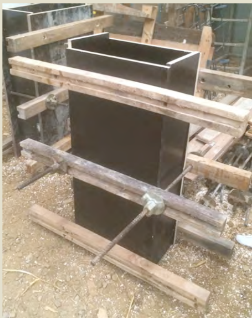
Imatge 5.1.2.9: Muntatge motlle fenòlic.
