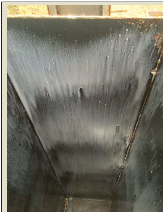
Imatge 5.2.2.2: Untat amb oli desencofrant DT (planxa).
