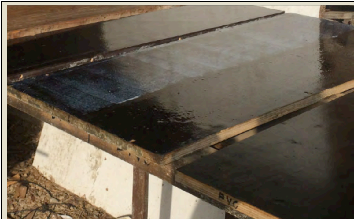
Imatge 5.2.2.5: Untat amb productes desencofrants. Desencofrant DT. (tonalitat blanca). Desencofrant DO (tonalitat transparent). Foto: Albert Coromina / Font: Pròpia
