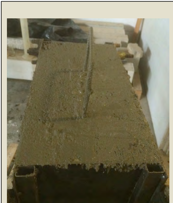
Imatge 3.2.39 : Regularització capa final amassada (3).
