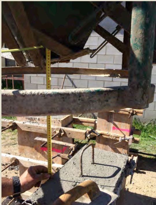
Imatge 4.35: Mesura alçada d'abocat.
