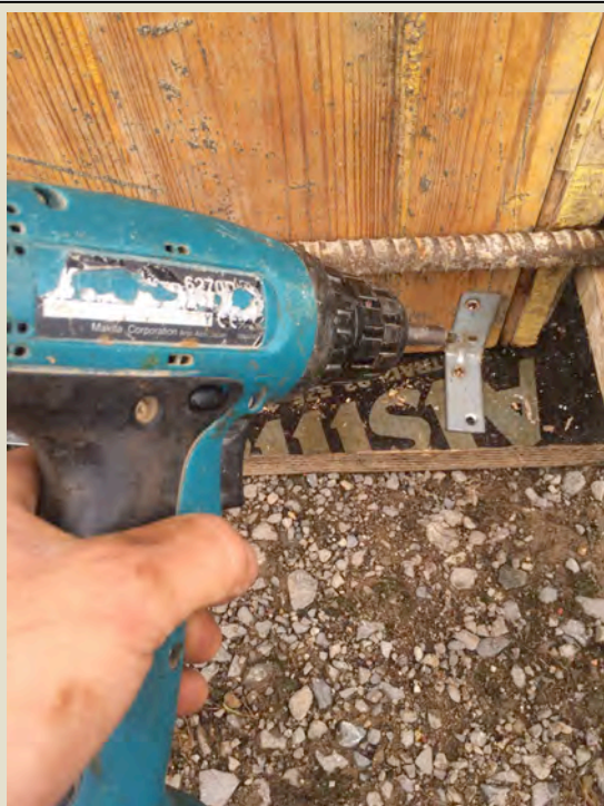
Imatge 5.1.2.11: Fixació taps inferiors (angles i bisos).
