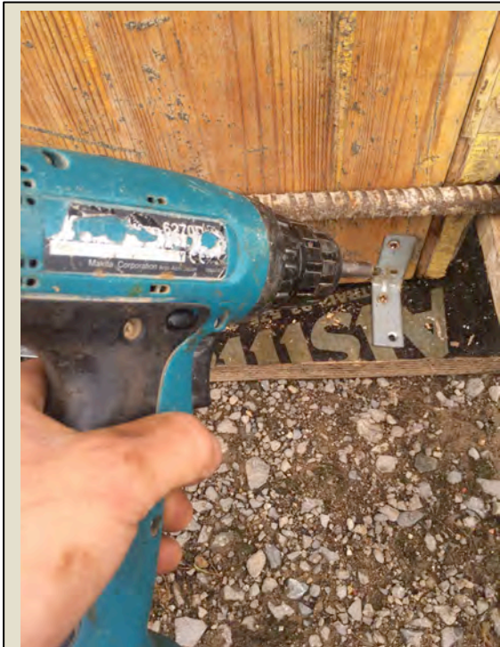
Imatge 4.23: Fixació taps inferiors (angles i bisos). Foto: Albert Coromina / Font: Pròpia
