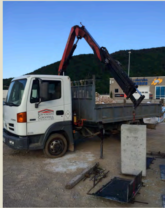
Imatge 4.52: Desencofrat amb camió grua. Foto: Albert Coromina / Font: Pròpia
