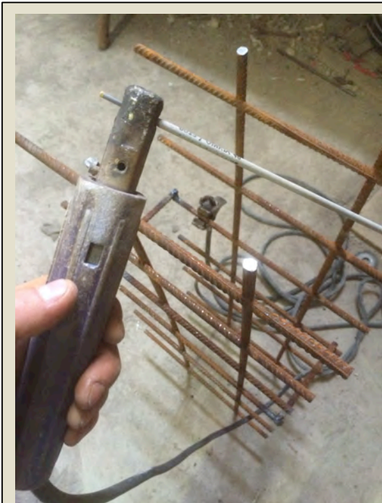
Imatge 4.11: Soldat amb elèctrodes de 2,5mm. Foto: Albert Coromina / Font: Pròpia
