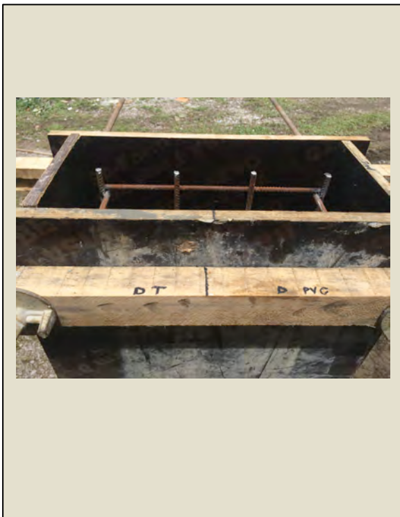
Imatge 5.2.2.8: Tauler fenòlic, (part esquerra desencofrant DT, part dreta desencofrant DO). Foto: Albert Coromina / Font: Pròpia
