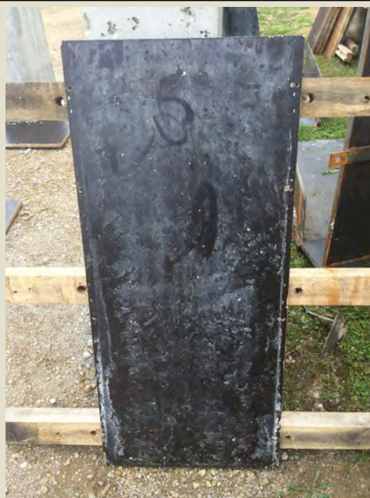
Imatge 4.2: Preparació material d'encofrat (tauler fenòlic de 18mm de gruix). Foto: Albert Coromina / Font: Pròpia
