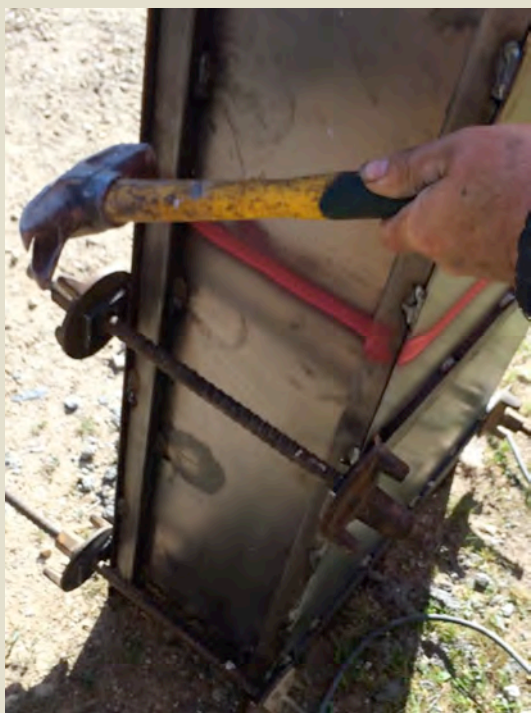
Imatge 5.3.2.12: Procés de desencofrat.
