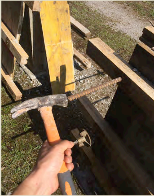
Imatge 4.51: Procés de desencofrat. (Picant amb martell d'encofrador). Foto: Albert Coromina / Font: Pròpia
