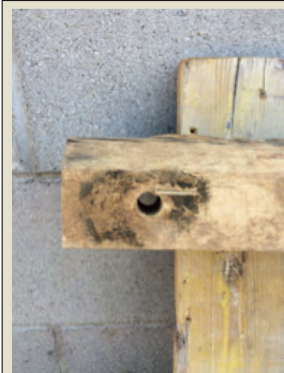
Imatge 4.5: Muntatge motlle fenòlic.
