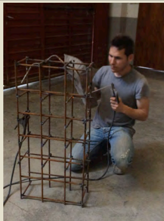
Imatge 4.10: Acabat de soldar i visualitzant soldadura. Foto: Albert Coromina / Font: Pròpia
