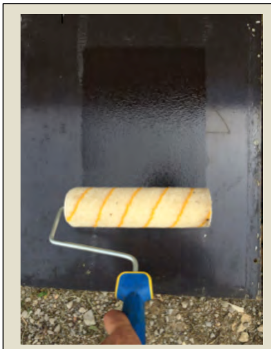
Imatge 5.3.2.4: Aplicació desencofrant amb rodet. Foto: Albert Coromina / Font: Pròpia
