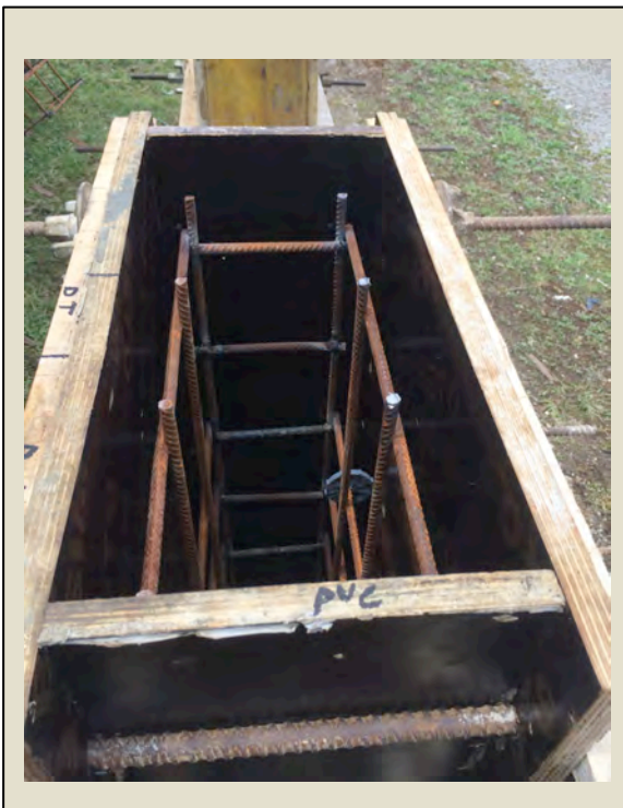
Imatge 4.27: Col·locació d'armat.
