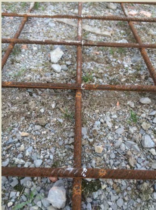
Imatge 4.7: Malla 15x15 Ø 10 marcada amb guix.
