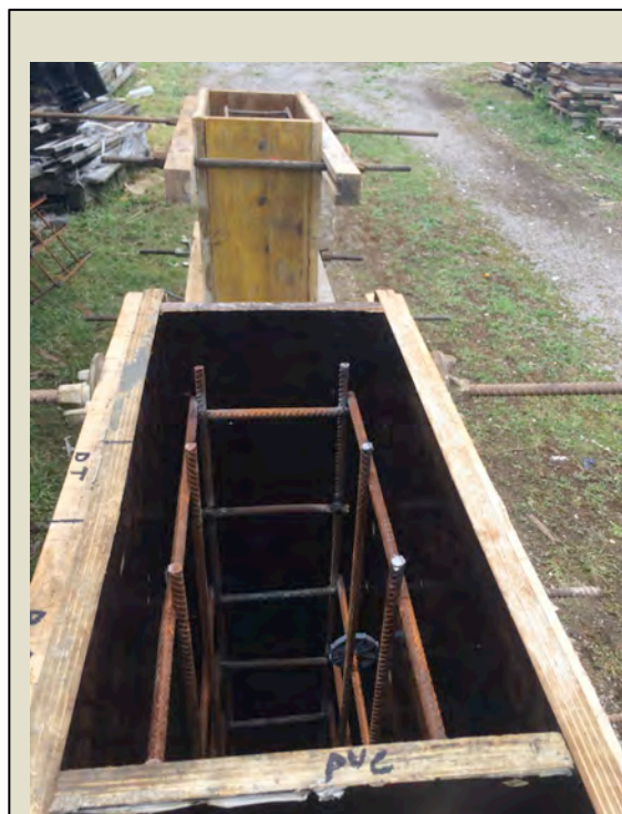
Imatge 5.2.2.7: Part esquerra, untada (DT) i (DC) i part dreta amb (DO). Foto: Albert Coromina / Font: Pròpia
