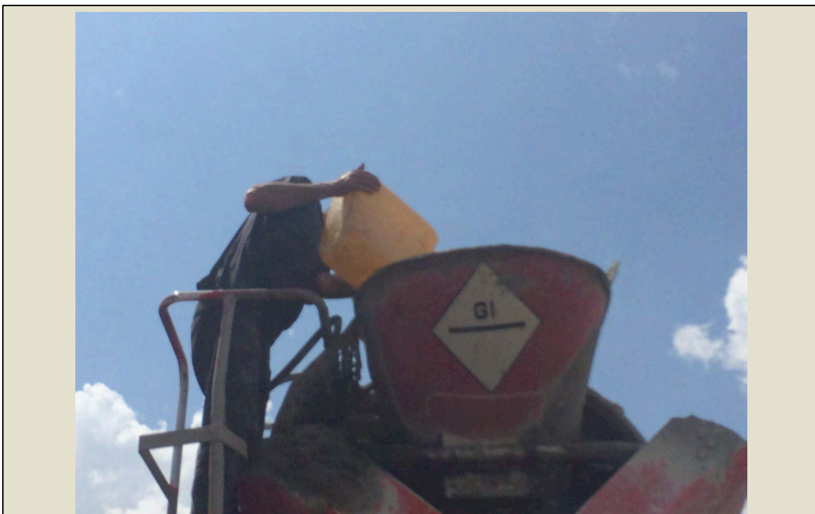
Imatge 5.2.2.18: Afegint 20 litres d'aigua i variant consistència del formigó.
