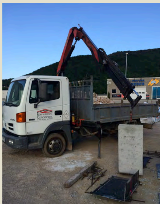
Imatge 5.1.2.27: Procés de desencofrat. (Molle de planxa). Foto: Albert Coromina / Font: Pròpia
