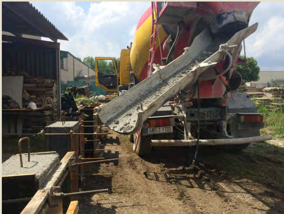
Imatge 5.2.2.14: Procés de formigonat assaig 3.
