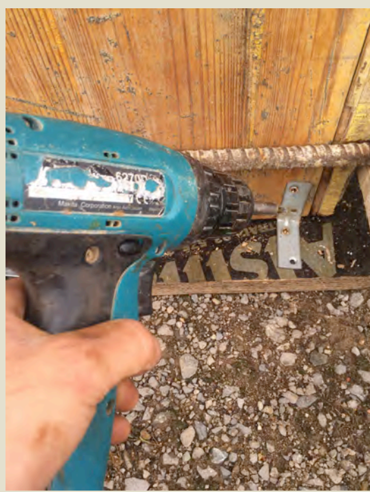
Imatge 5.3.2.13: Procés de desencofrat.
