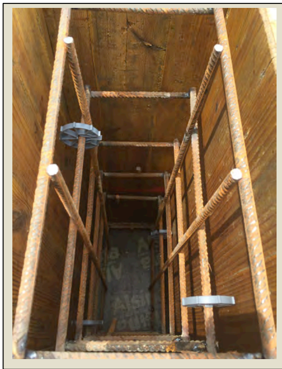
Imatge 5.1.2.14: Col·locació de separadors.
