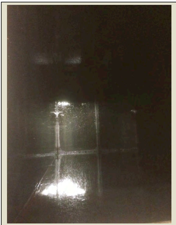
Imatge 5.1.2.5: Untat amb oli desencofrant (planxa). Foto: Albert Coromina / Font: Pròpia
