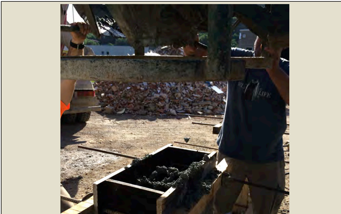
Imatge 5.2.2.15: Procés de formigonat. Abocat amb cubilot assaig 3.
