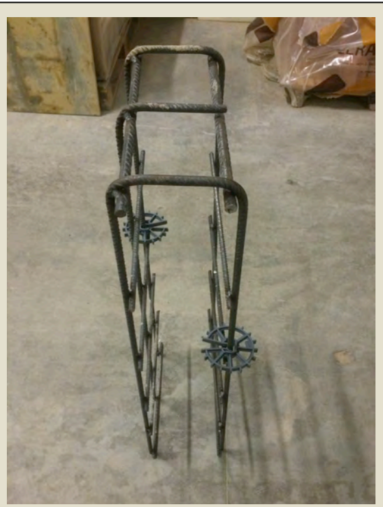
Imatge 4.26: Col·locació de separadors.
