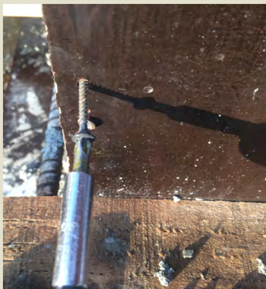
Imatge 5.1.2.26: Procés de desencofrat 1,5 dies després del formigonat. (descollant bisos). Foto: Albert Coromina / Font: Pròpia
