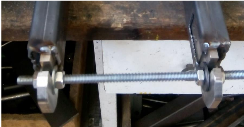
Figura E.17 Estat de repòs dels anclatges ja soldats al basculant mitjançant un utillatge
