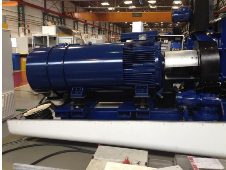
Figura 20. Generador de la V44
