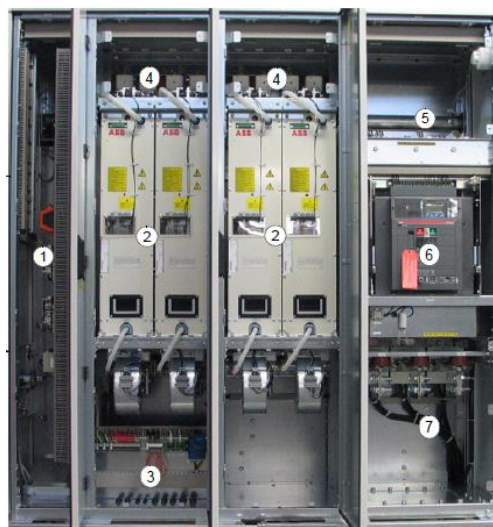
Figura 27. Distribució de la part de la INU del convertidor ACS800-77
