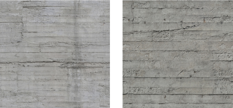
imatges de referència_ acabat exterior del mur de formigó amb formigó porós “viu”
