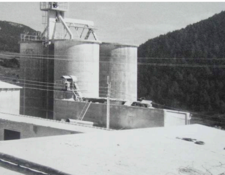
Vista des de la coberta als forns i silos, 1968. Font: Xavier Gironès (Uralita)
