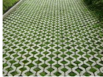
Fig.7. Paviment permeable amb llambordins vegetals o ecològics. Font: sfbetterstreets
