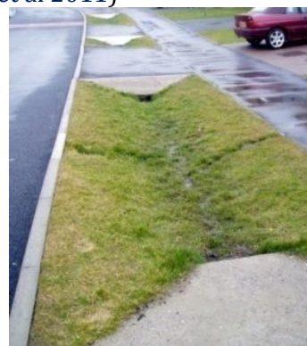
Fig.9. Rases de retenció o trinxeres urbanes. Font: Itwh
