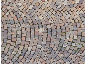
Fig.6. Paviment permeable amb llambordins Font: sfbetterstreets
