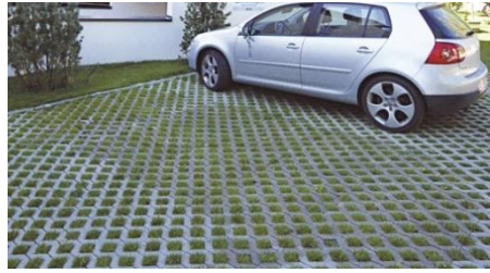
Fig.25. Exemple d'un aparcament amb llambordins vegetals o ecològics permeables. Font: Sfbetterstreets
