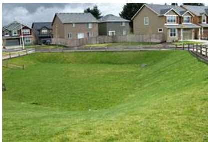
Fig.12. Exemple d'estany de detenció amb l'aigua ja infiltrada Font: EPA
