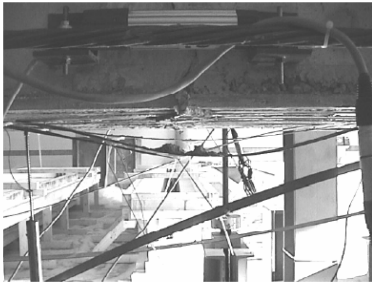
Figura B.19. Detall de la junta central entre dovelas després de l'assaig VD-CFK1 (Font: [1])
